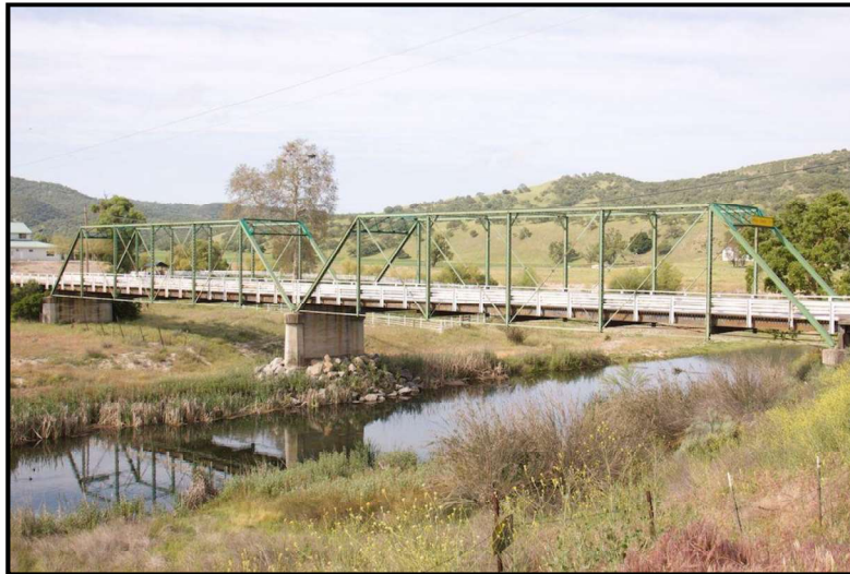
Existing Nacimiento Lake Drive Bridge
